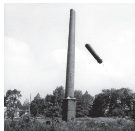
Stückweise Niederlegung eines Kamins im Jahr 1965
