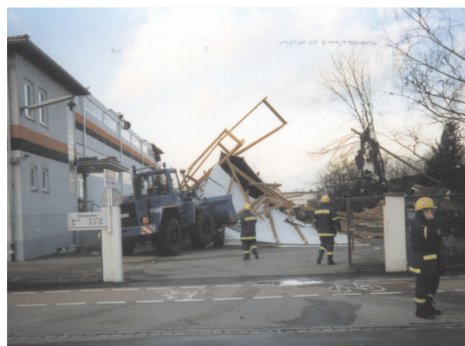
Einsatz des Bergungsräumgerätes bei Sturmschäden
