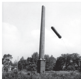
Stückweise Niederlegung eines Kamins im Jahr 1965
